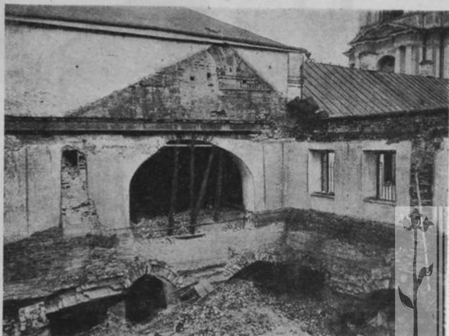
Рис. 39. Цер. св. Николая съ западной стороны во время перестройки.
