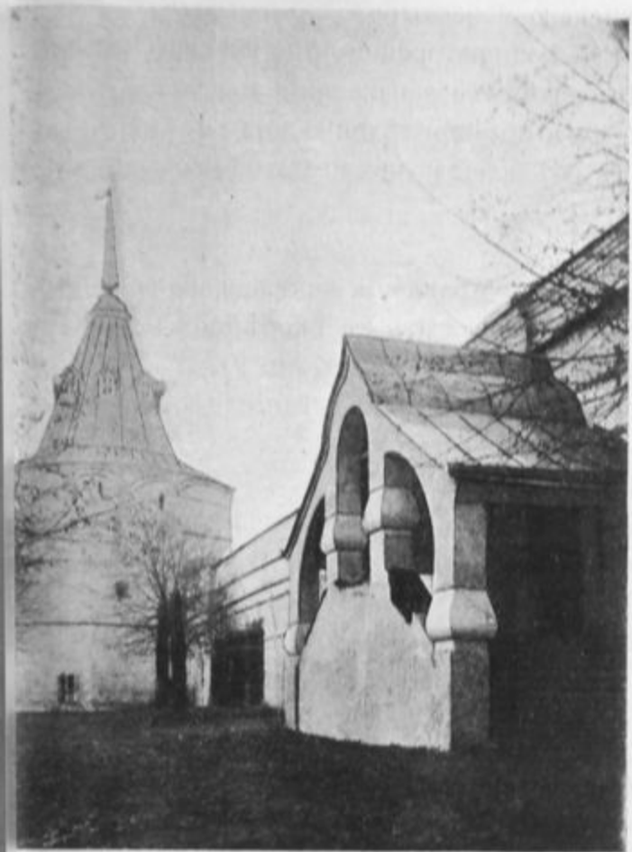
Рис. 42. Ворота и входъ вновь устроенныя въ стѣнѣ.
